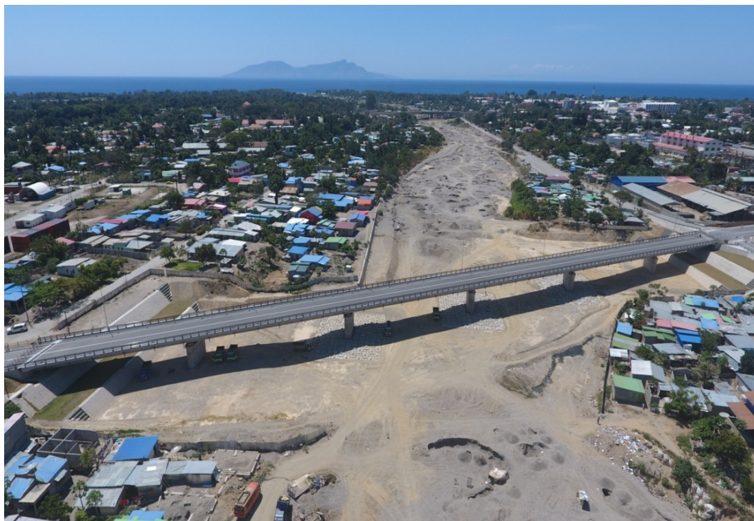
完成したコモロ川上流新橋（下流側を見る）
